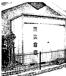
防災倉庫を設置
