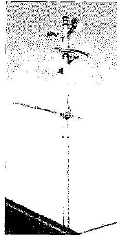
城北コミュニティセンターの防災行政無線塔
