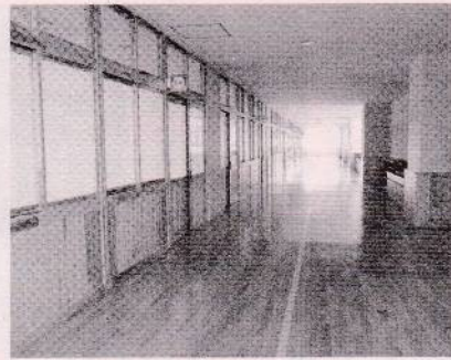
広々とした木製廊下と教室
