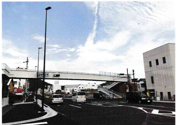
装いも新しくなった県道33号(土居町)
